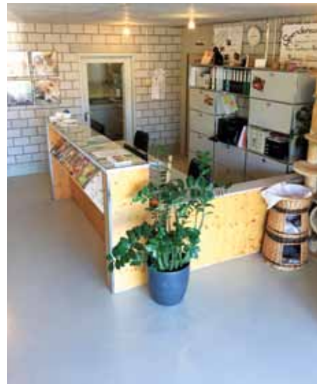
Der neue Bodenbelag im Gang und in den Zimmern ist hygienischer und einfacher zu reinigen.
