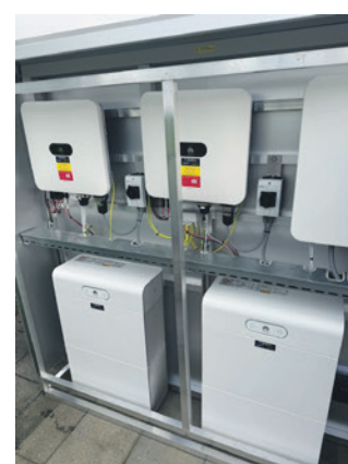
Die Batterie und Steuerung wurden neu installiert. Bild: TSV Zug
