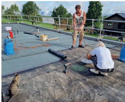
Die Dachsanierung wurde von unserem Tierheimbüsi überwacht: Mitten im laufenden Betrieb wurde das Flachdach fachgerecht erneuert – für mehr Sicherheit und Geborgenheit.
